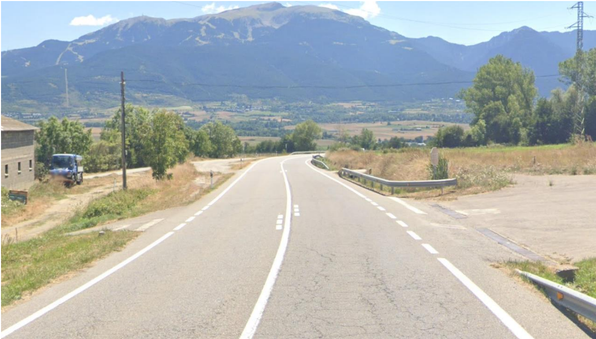
Tramo con mayor índice Riesgo en la carretera N-260 (Ger, Cataluña)
